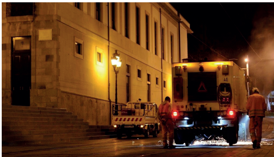
Trabajos de amolado de los carriles frente al Teatro Guimerá.
